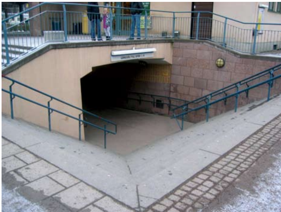
Bild 9. Nedgång till tunnelområdet. I bakgrunden skymtar stationsbyggnaden.
