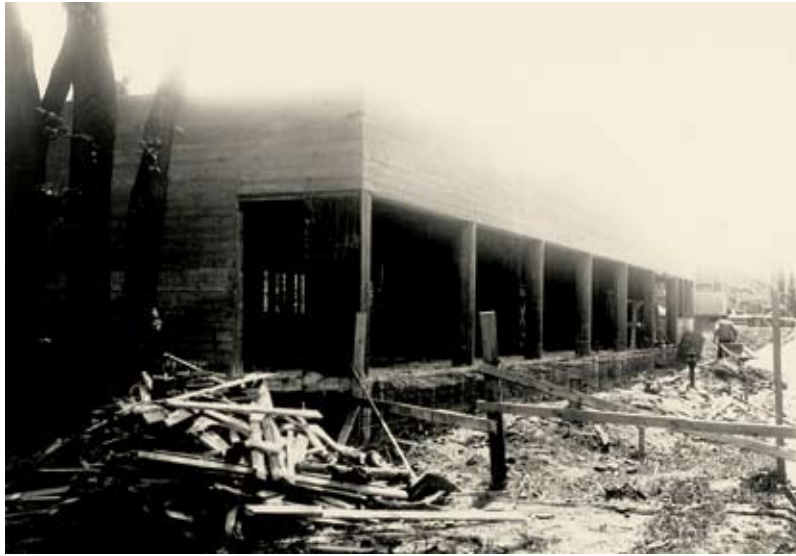
Bild 12. Från byggnationen på baksidan, vid postförvaringsrummet och truckgarage.
