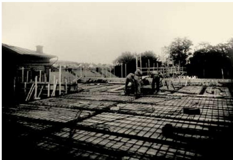
Bild 11. Gjutningsarbete på taket. Notera "mattorna" av gjutjärn. I bakgrunden till vänster skymtar den gamla järnvägsstationen.
