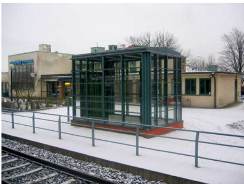
Bild 7. Hisshus. Hissen leder från tunnelområde och upp till markytan. Spröjsverket har samma proportioner som spröjsverket i fönstret till stora väntsalen.
