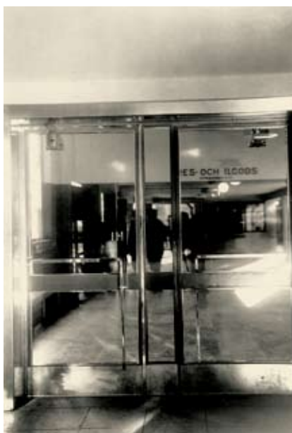
Bild 18. Entrépartiet från spårområdet. Dörrpartierna i stål är i modernistisk stil och fungerar även för att öka ljusinsläpp. Lägg märke till bokstäverna inne i rummet med sitt tidstypiska typsnitt. Detaljerna samverkar med helheten.
