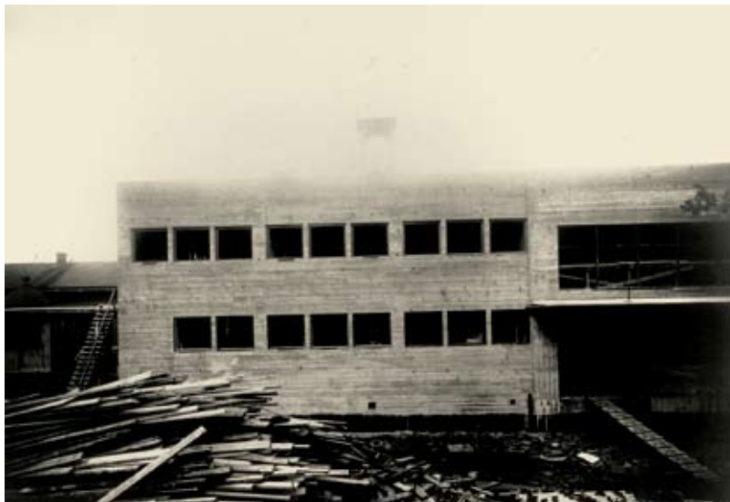
Bild 13. Partiet vid huvudentrén färdiggjuttet i armerad betong. I förgrunden ligger troligen allt formvirke.
