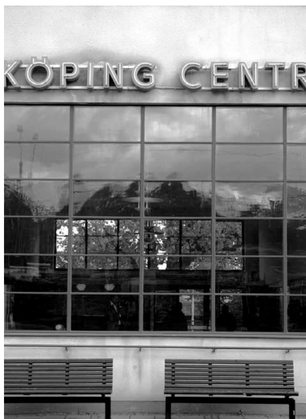
Bild 6. Väntsalens fönster, vilket vetter mot spårområdet. Spröjsverket är tidsenligt av stål. Lägg märke till neonbokstäverna - utförda i ett för den tidiga modernismen karakteristiskt linjärt typsnitt.
